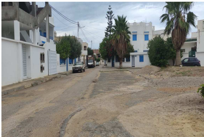
Voies de Lotissement Gammar (zone 2) – revêtement existant en bicouche dégradé
