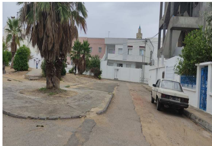
Voies de Lotissement Gammar (zone 2) – revêtement existant en bicouche dégradé
